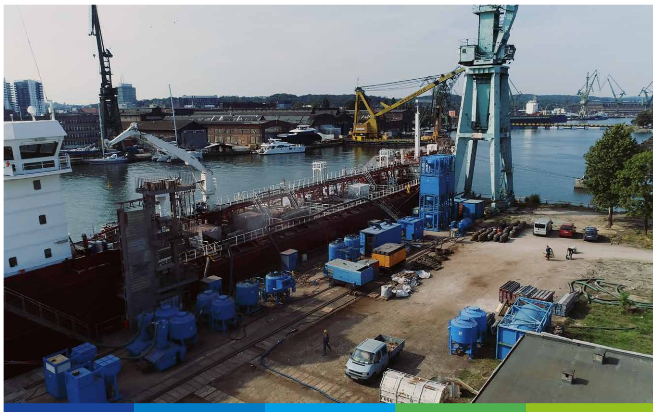
Oberflächenschutzarbeiten an und in einem Schiff
