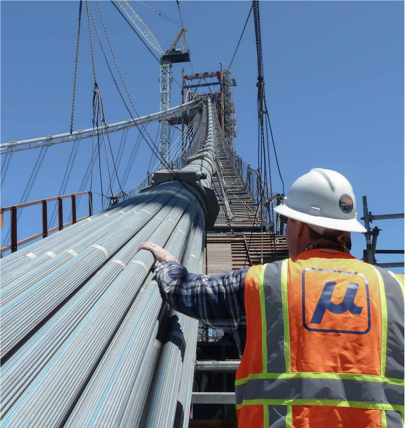
Oberflächenschutzarbeiten an einer Stahlbrücke in den USA
